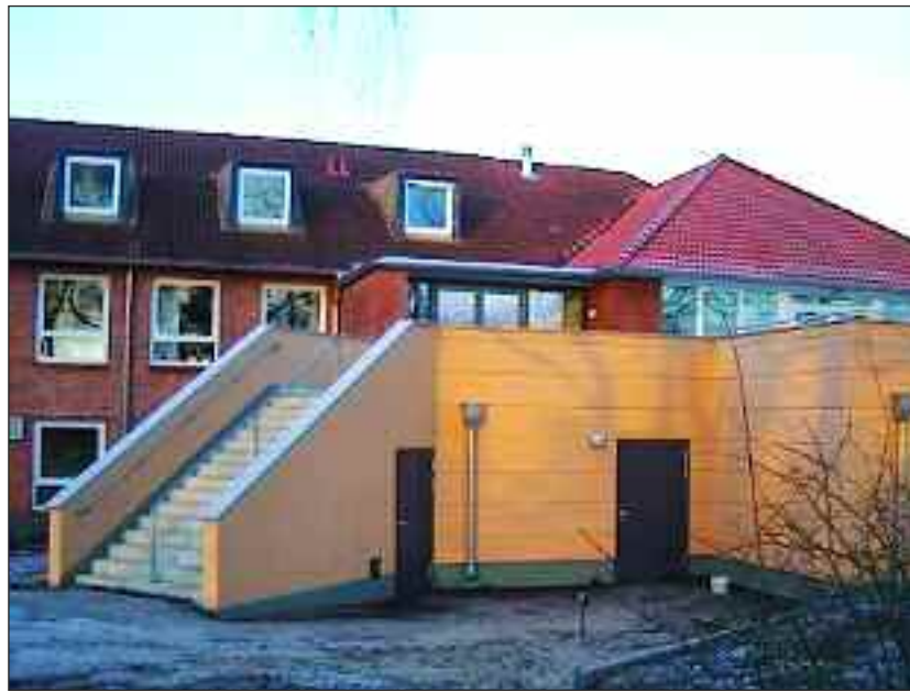
Nye udsigter. Den store nye terrasse bag huset og hyggestuerne er en væsentlig del af ombygningen.
